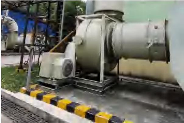
图 3-16 现有风机加装减震底座降噪
