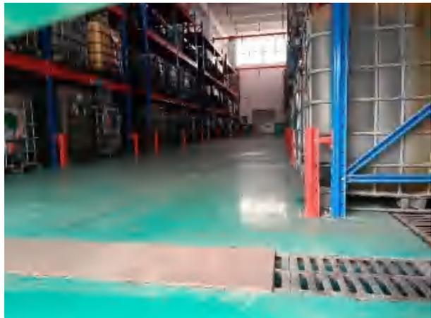
图 3-4 废液收集槽、导流沟
