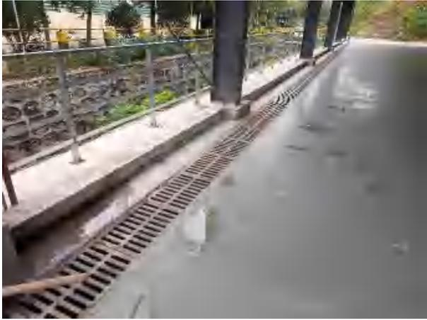
图 3-5 危废接收登记车棚废液收集沟
