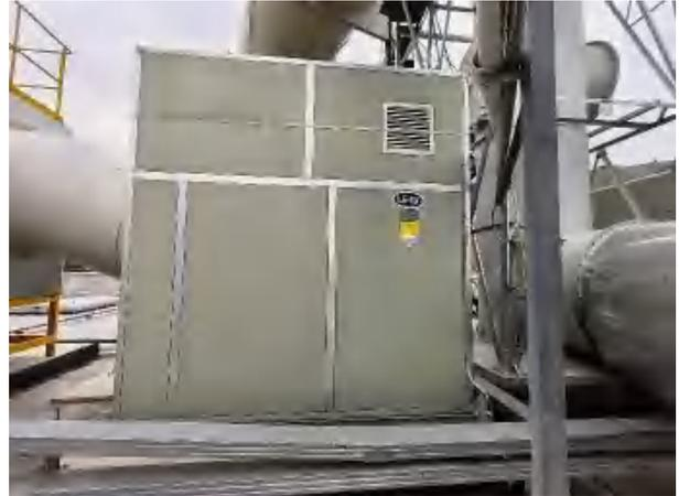
图 3-17 新建风机加装隔音罩降噪
