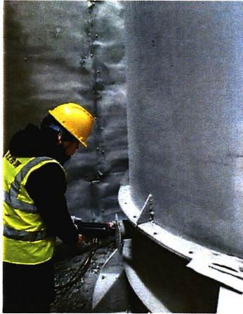
DA122 C1 线水泥磨排气筒
